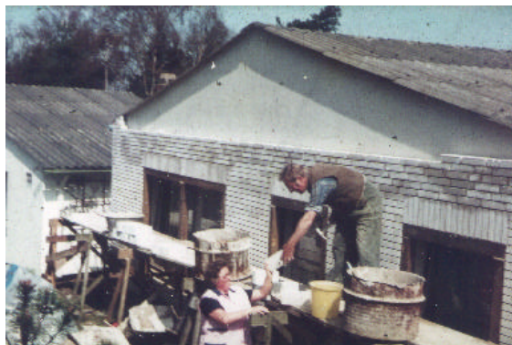
Weisser Kalksteinverblender und neue Fenster. Wilma als Handlanger.
